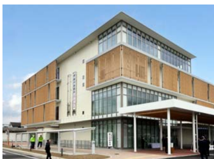
竣工した下妻市庁舎（外観）
